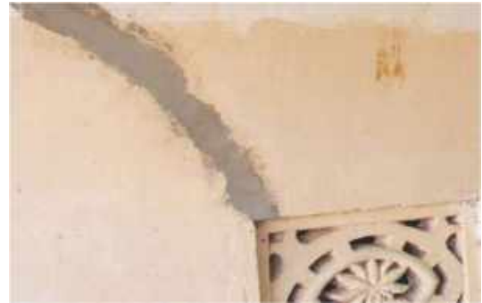
दरार में सीमेन्ट-बालू का 1:3 के अनुपात में मसाला भरें।
