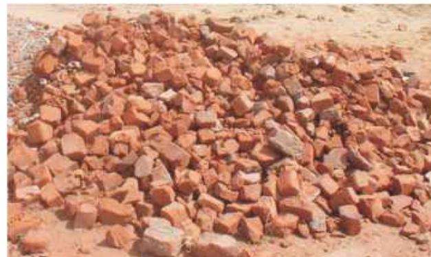
टूटी ईंटों को पास रखें ताकि साबुत ईंटों को तोड़ना ना पड़े।
